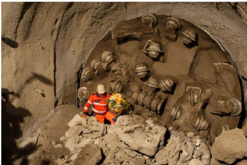
Abb. 5: Stollendurchschlag zum TB 21 - Silviastollen der Diabaswerke Saalfelden GmbH Foto Heugenhauser
